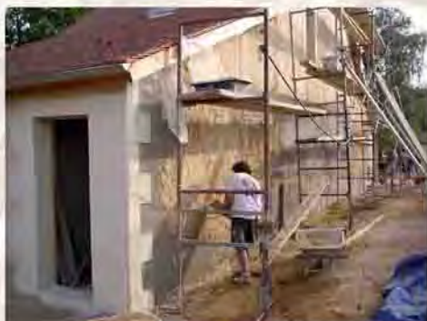
Isolation par l'extérieur d'une maison et enduit à la chaux
