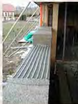
pose de briques de 30 cm au mortier de chaux
