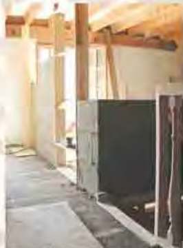
Montage de cloisons briques de 10 cm
