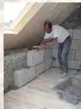
Doublage de murs en combles
