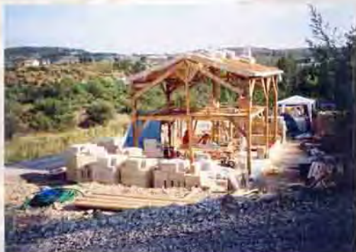
structure bois poteau-poutre destinée à recevoir des murs en briques de chanvre
