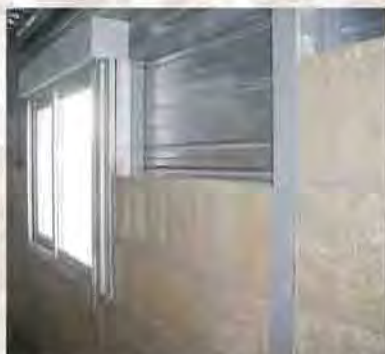
Isolation de bâtiments industriels Construction de bureaux
