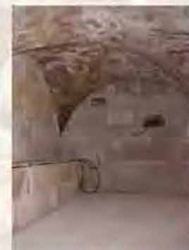
Isolation des murs d'une pièce voûtée
