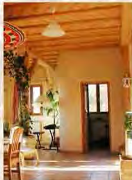
Cloison courbe et menuiserie bois
