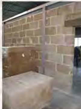
Cloisons de bureaux
