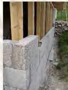
briques de 15 cm sur structure bois rapprochée
